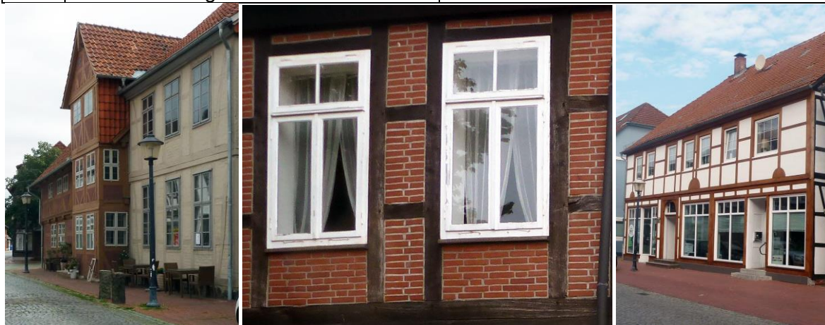
Foto 1: denkmalgerechte gut ausgeführte Fassadensanierung mit gegliederten Holzfenstern und verputzten Gefachen (Einzeldenkmal Lange Straße 59).
