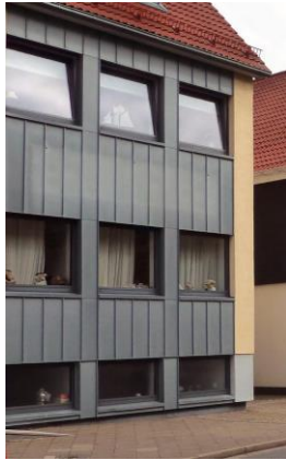
Foto 1: Vorgehängte hinterlüftete Fassade mit Blechbelag als ortsuntypischer und unpassender Fassadenbelag
