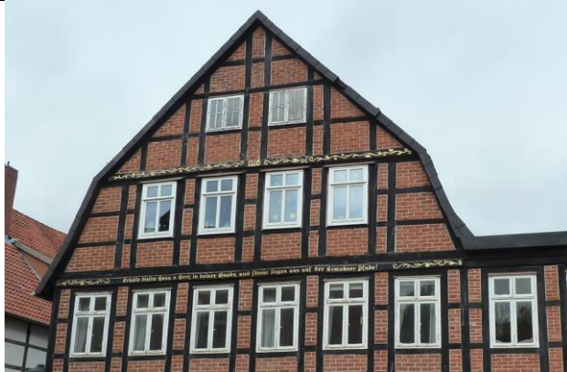
Fotos: Gänsemarkt 2 und 3 (links) und Einzeldenkmal Lange Straße 35 (rechts). Erhaltenswerte und stadtbildprägende, durch Fachwerkelemente und hochrechteckige Fenster gegliederte Fassaden. Die Abstände werden durch traditionelle konstruktive Elemente des Fachwerkbau vorgegeben.
